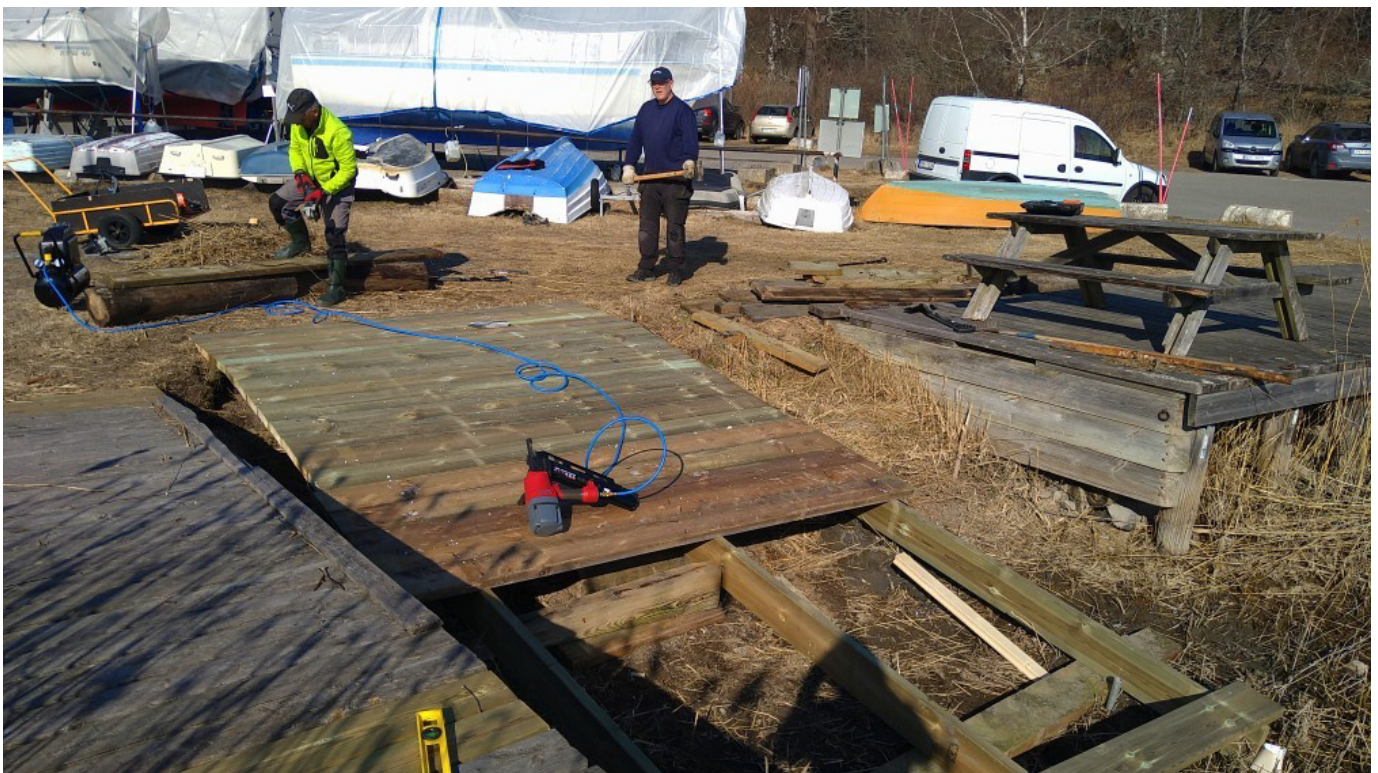
Renovering av lilla rampen. Foto: Thomas Wallin
